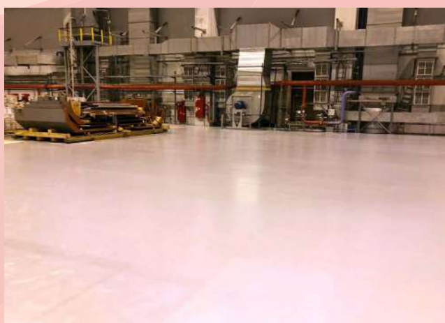
Ленинградская АЭС-2, энергоблок №1 здание турбины, Ленинградская обл., г. Сосновый Бор, ул. Ленинградская
