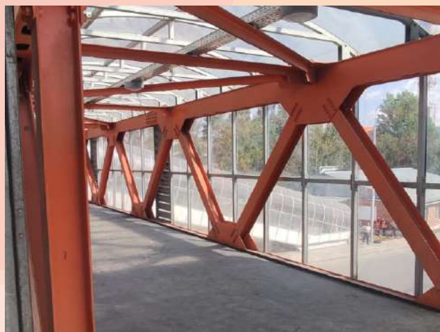
Реконструкция автомобильной дороги. г.Лобня, аэропорт Шереметьево
