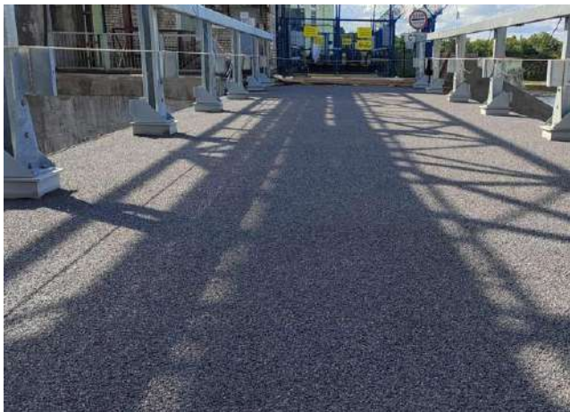
Пешеходный мост Волховской ГЭС, г.Волхов
