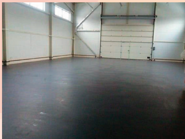
Депо «Планерное», помещение склада, Москва, ул. Планерная, 9
