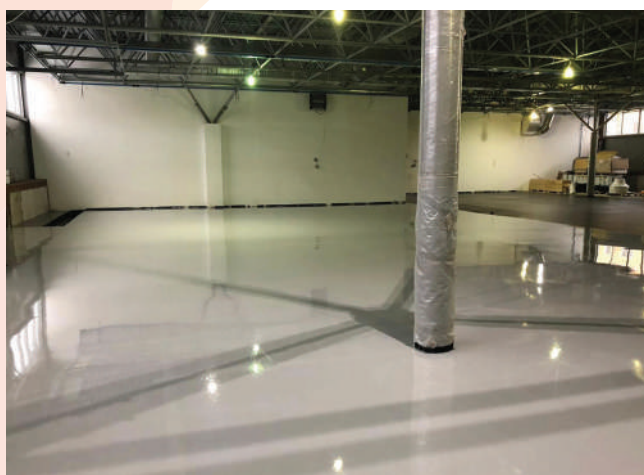
Производственное здание в Зеленограде, МО, Зеленоград, ул. Заводская, 1Бс7
