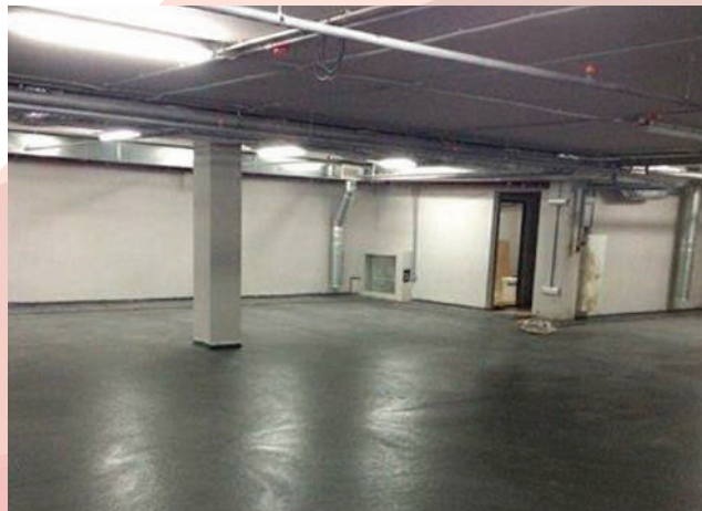
БЦ по адресу Москва, ул. Николаямская 22
