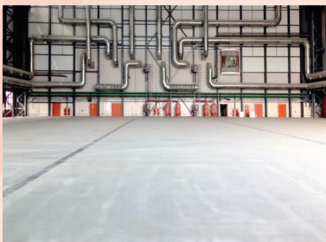
Вторая секция ангарного комплекса в аэропорту Внуково, Москва, Заводское шоссе, 15
