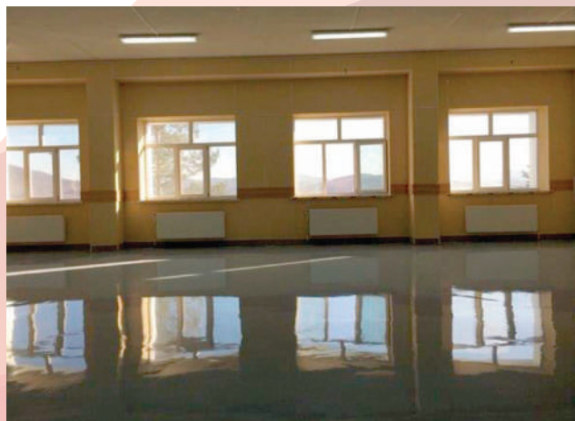
Воинская часть 16871, учебный корпус, г. Сибирцево
